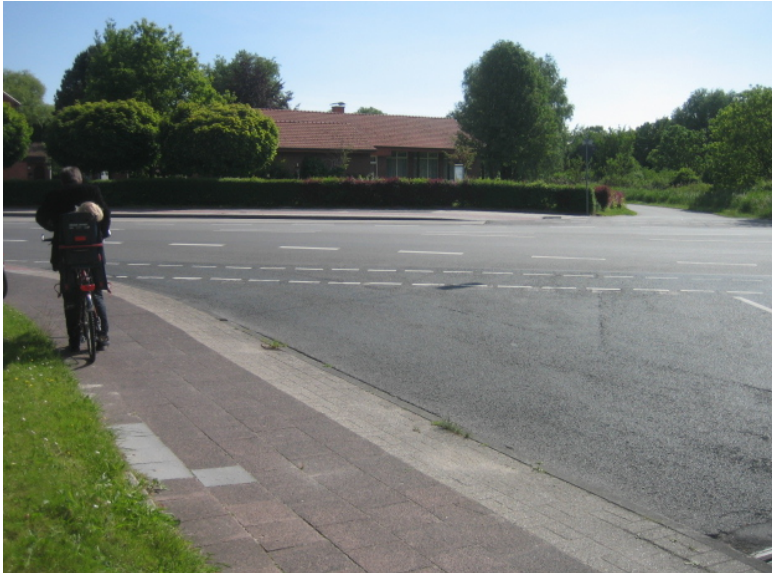
Abbildung 64: Vom Zweirichtungsradweg Rüstersieler Straße aus muss der Hermann-Löns-Weg (rechts oben) erreicht werden
