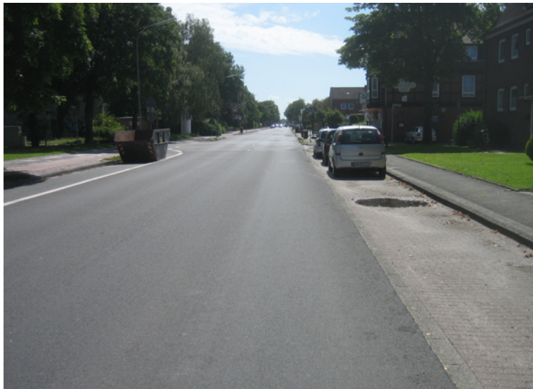
Abbildung 62: Flutstraße südlich des Verkehrsknotens
