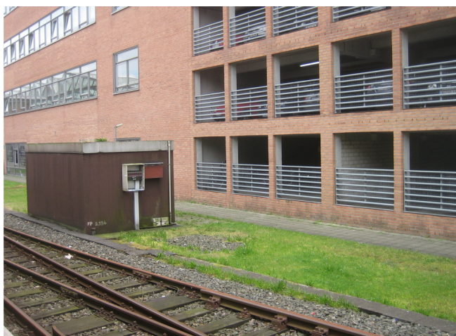
Abbildung 95: Ein ausbaufähiger Standort für ein Fahrradparkhaus mit direktem Zugang zum Gleis ist vorhanden
