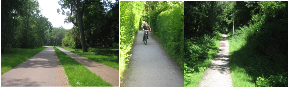
Abbildung 38: Unterschiedliche Streckenabschnitte an städtischen Fahrradrouten: links: Parkmittelweg, Mitte: Am Friedhof, rechts: Kniphauser Deich
