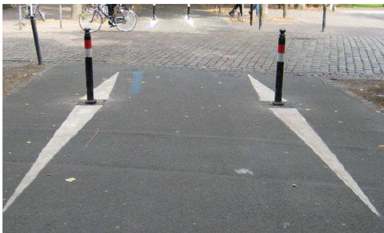
Abbildung 55: Markierung als Sicherung gegen Aufprall
